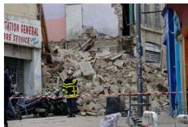
Les immeubles effondrés de la rue d'Aubagne, à Marseille. © Reuters
