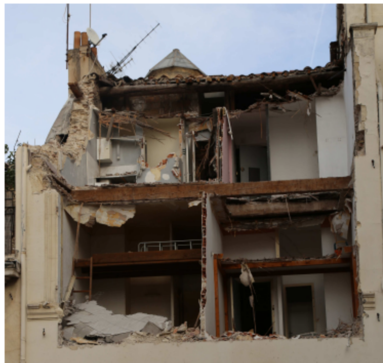
La « déconstruction » en extrême urgence des 41 et 43, rue de la Palud est une opération ordonnée par la Ville et réalisée à ses frais. PHOTO OUISSEM GOMBRA
