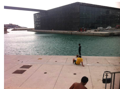
Derniers travaux du Mucem, au printemps 2013. © LF
